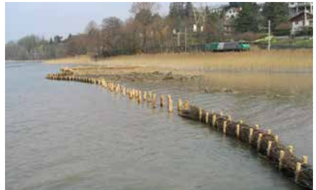
Photo 1 – Fascine végétale pour protéger la roselière de la baie de Mémard au lac du Bourget (© CISALB)
