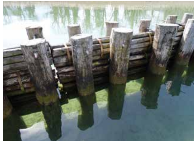
Photo 2 – Ouvrage de protection sur le lac d'Annecy de type « fascine imputrescible » (© D. Zanella – SILA)
