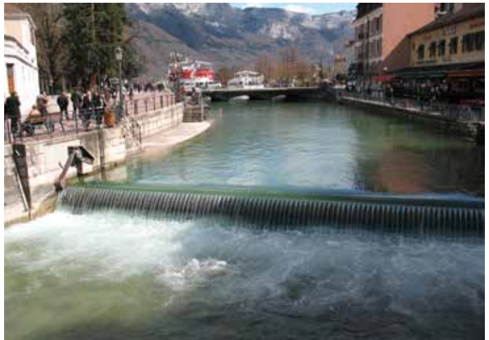
Photo 3 – Vanne de régulation du lac d'Annecy située sur son émissaire, le Thiou (© D. Zanella – SILA)
