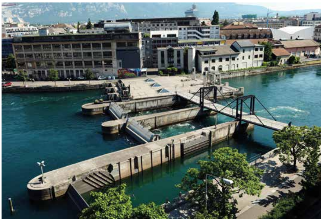
Photo 1 – Barrage du Seujet sur le Léman (© J. Louvion)
