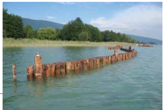
Photo 2 – Ouvrage de protection sur le lac d'Annecy de type « fascine imputrescible » (© D. Zanella – SILA)
