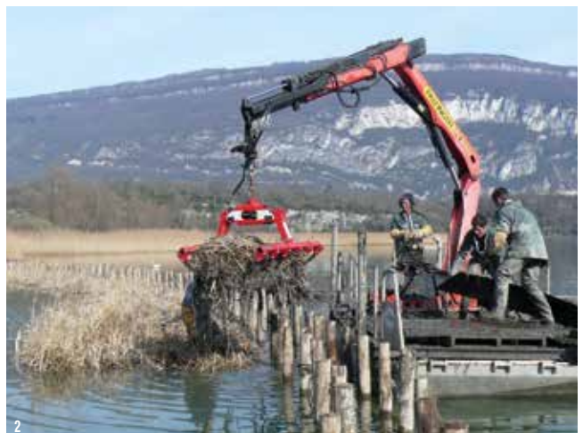
Restauration de la roselière de la baie de Portout au lac du Bourget. ◀
